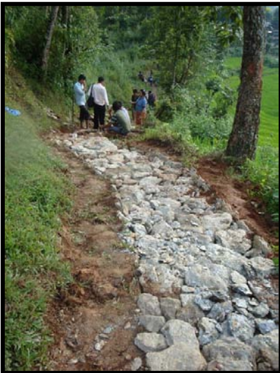
Stenbeläggning som sen ska gjuta cement på.
